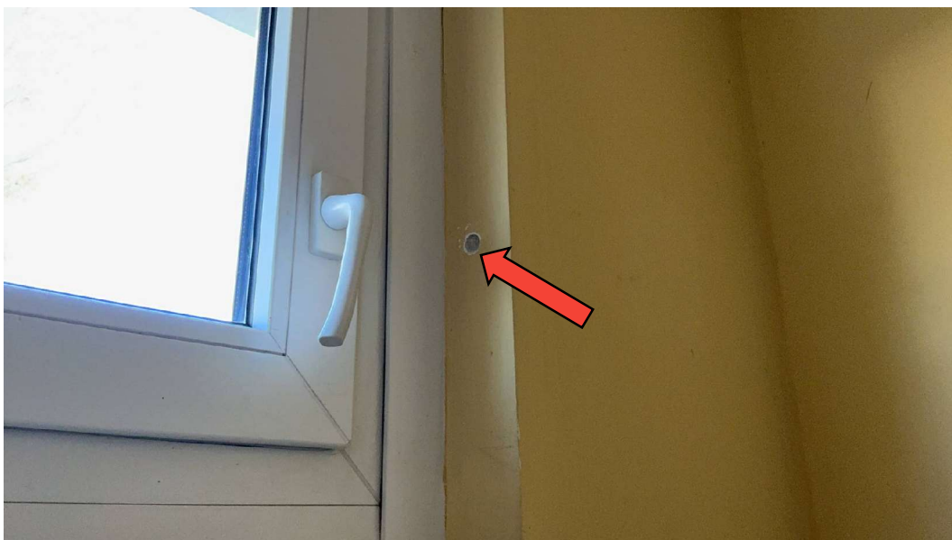
Foto 6 Asbest Befund: Spachtelmasse / Farbe an Betonwänden, Nr. 33, TRH, vgl. MP6
