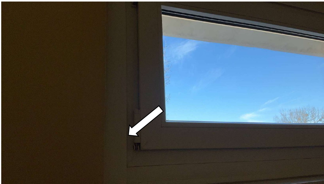
Foto 20 Ohne Befund: Bauschaum in Fensterlaibung, Nr. 33, EG, TH
