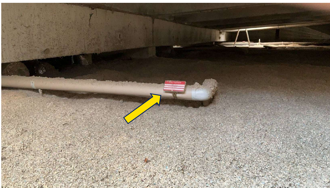
Foto 16 KMF-Befund: KMF-Dämmung um Rohrleitung mit PVC-Mantel, alukaschiert; Drempe
