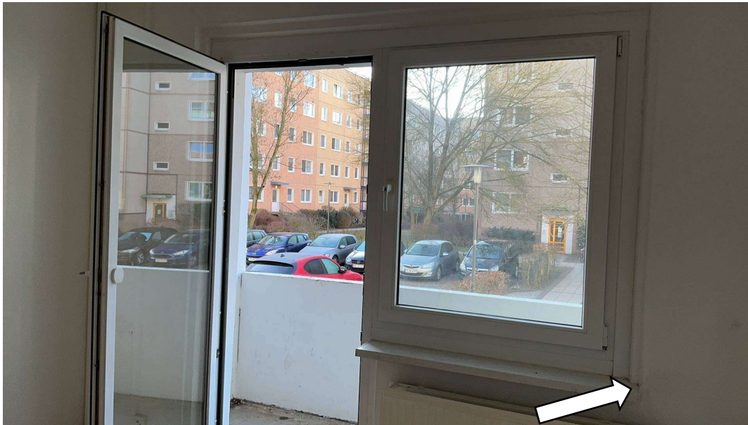
Foto 21 Ohne Befund: Bauschaum in Fensterlaibung, EG
