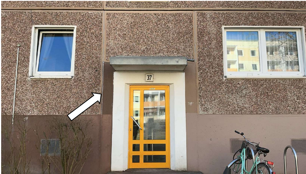
Foto 11 Ohne Asbest Befund: Fugendichtstoff zwischen Betonplatten, Fassade, Nr. 37, vgl. P9
