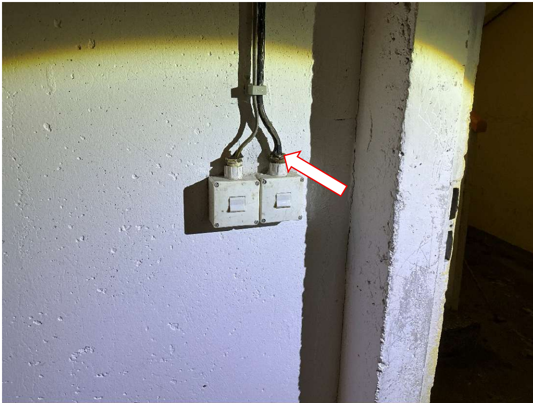
Foto 15 Asbest-Befund: Kitt an Kabeleinführungen von Elektrobauteilen, KG,
