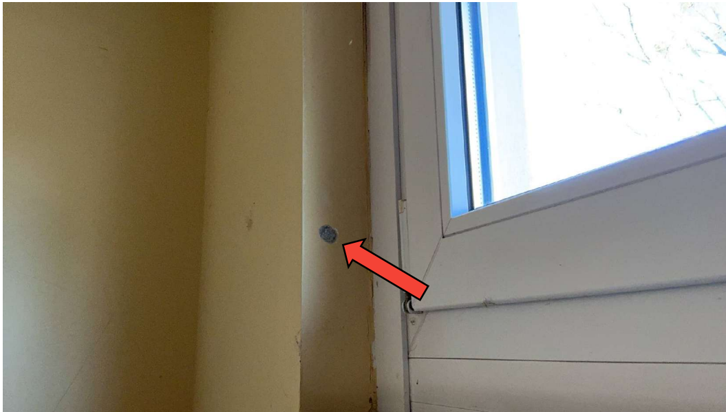
Foto 5 Asbest Befund: Spachtelmasse / Farbe an Betonwänden, Nr. 33, TRH, vgl. MP6
