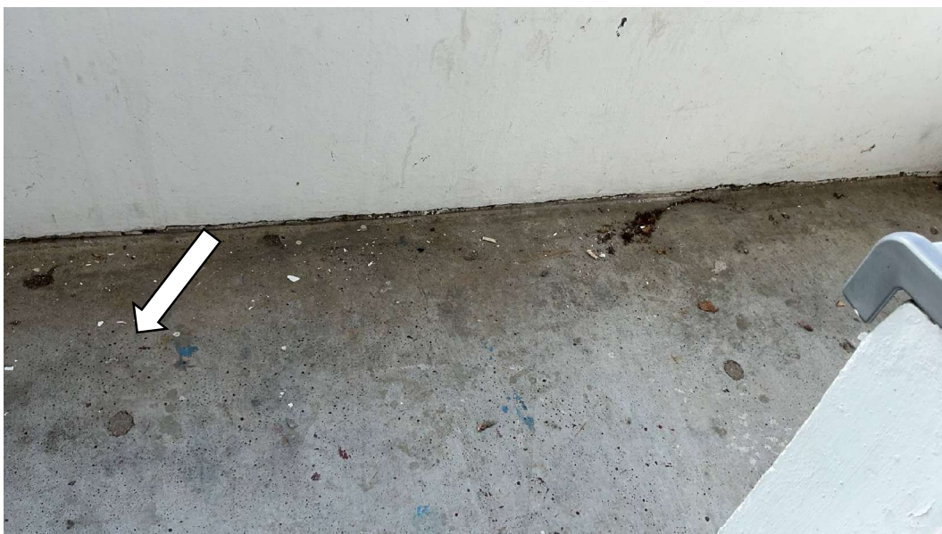
Foto 22 Ohne-Befund: Betonfertigteil-Balkon, EG
