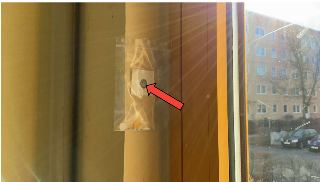
Foto 4 Asbest Befund: Spachtelmasse / Farbe an Betonwänden, Nr. 33, TRH, vgl. MP6
