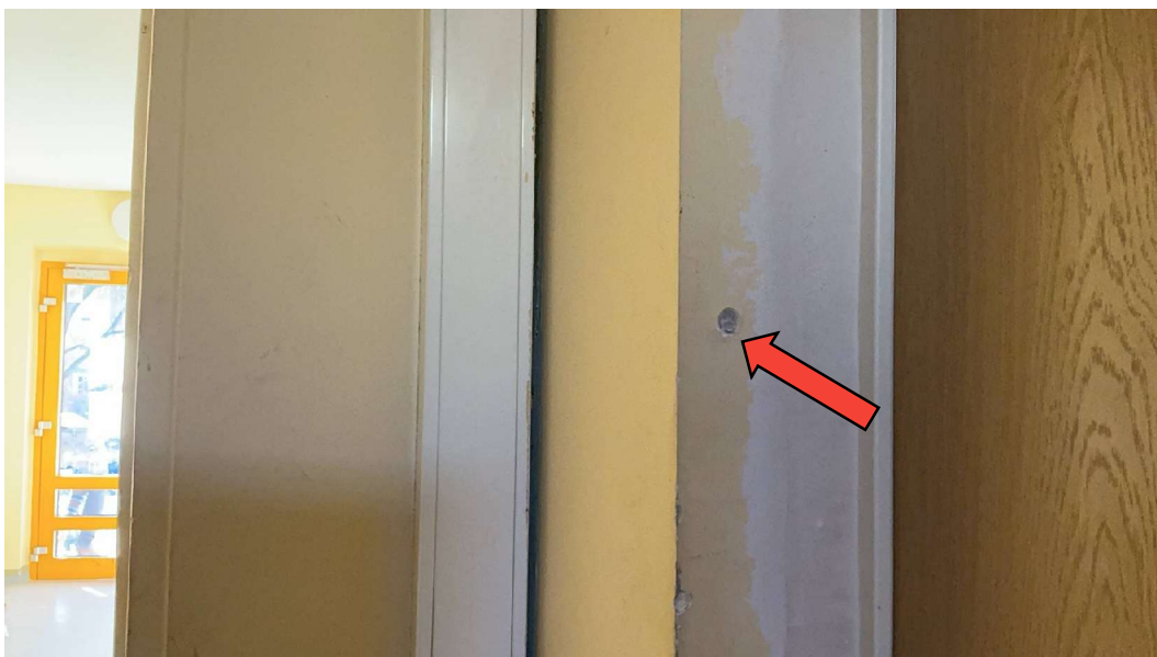
Foto 8 Asbest Befund: Spachtelmasse / Farbe an Betonwänden, Nr. 33, TRH, vgl. MP6
