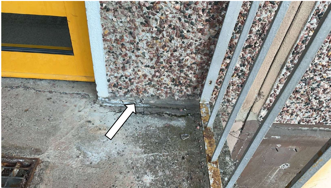
Foto 9 Ohne Asbest Befund: Fugendichtstoff zwischen Betonplatten, Fassade, Nr. 37, vgl. P7
