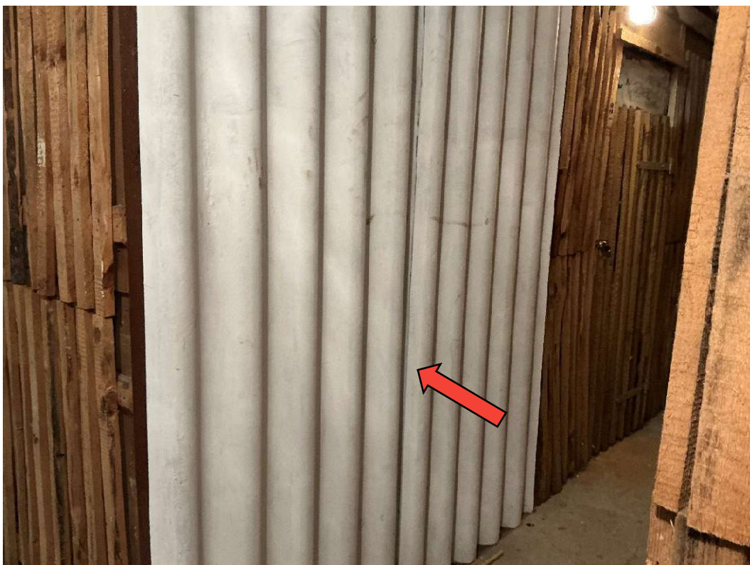
Foto 14 Asbest Befund: Asbest-Wellplatten, KG
