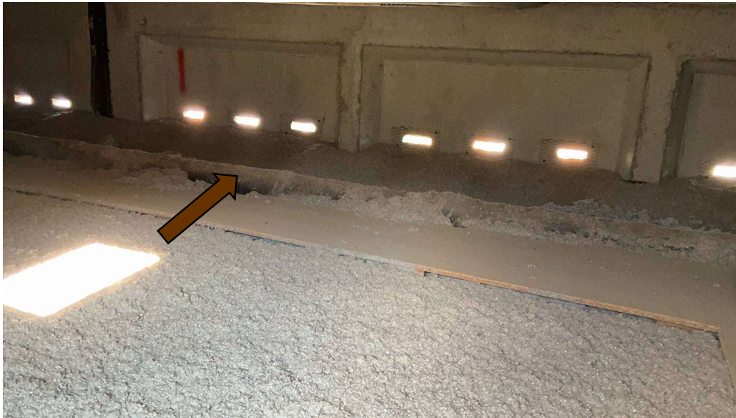
Foto 3 Ohne Asbest-/ KMF-/PAK - Befund: schwarze Abdichtungsbahn, papierkaschiert, um KMF-gedämmte Rohrleitung, Drempel, vgl. P4
