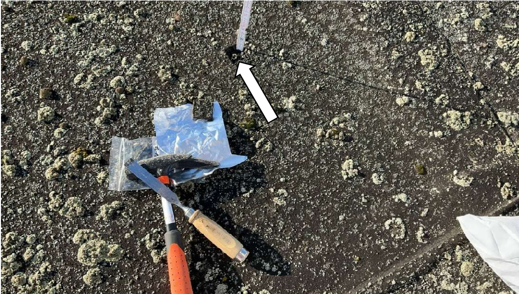
Foto 1 Ohne Asbest-/ KMF-/PAK - Befund: Abdichtungsbahn auf Betondach, vgl. P2
